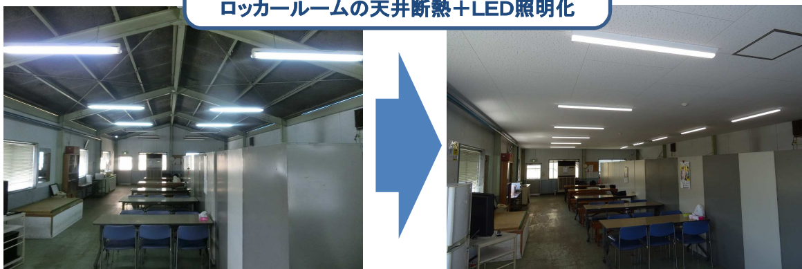
ロッカールームの天井断熱+LED照明化
