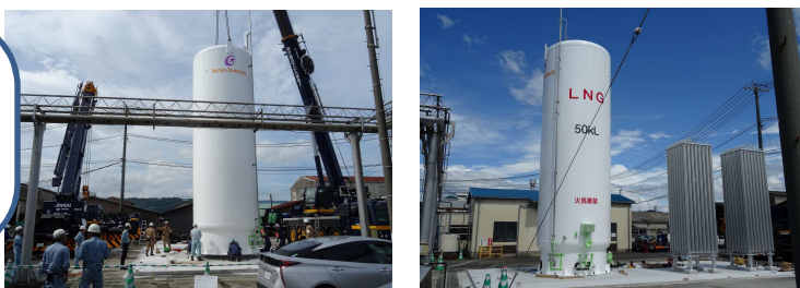
ボイラ燃料転換工事中 LSA重油 → LNG (2018年8月完成予定)
