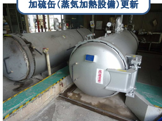
加硫缶(蒸気加熱設備)更新
