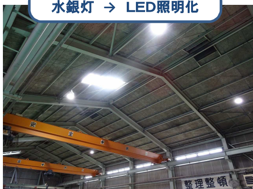
水銀灯 → LED照明化
