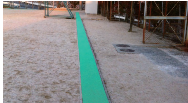
(施工後:BOC-07 ライトグリーン)
