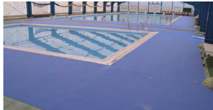
(施工後:BOC-07 ライトブルー)
